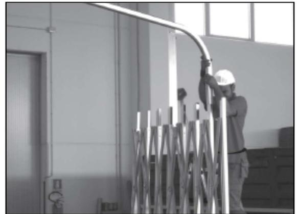
Einer der beiden Bögen mit der PVC-Giebelfläche ist auf das erste Profil zu montieren, dabei muss das Verschlussgummiband, das an dem Bogen befestigt ist, an die C-Haken der Seitenstruktur angepasst werden. (Foto 8 und 9).
